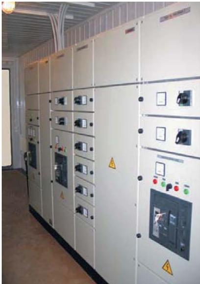
РУ-0,4 кВ выполнено на базе НКУ ЩО-2000 «Нева», которое состоит из модульных элементов и позволяет создавать щиты любой конфигурации в стационарном или выдвижном исполнении с различными вариантами разделения функциональных узлов.
