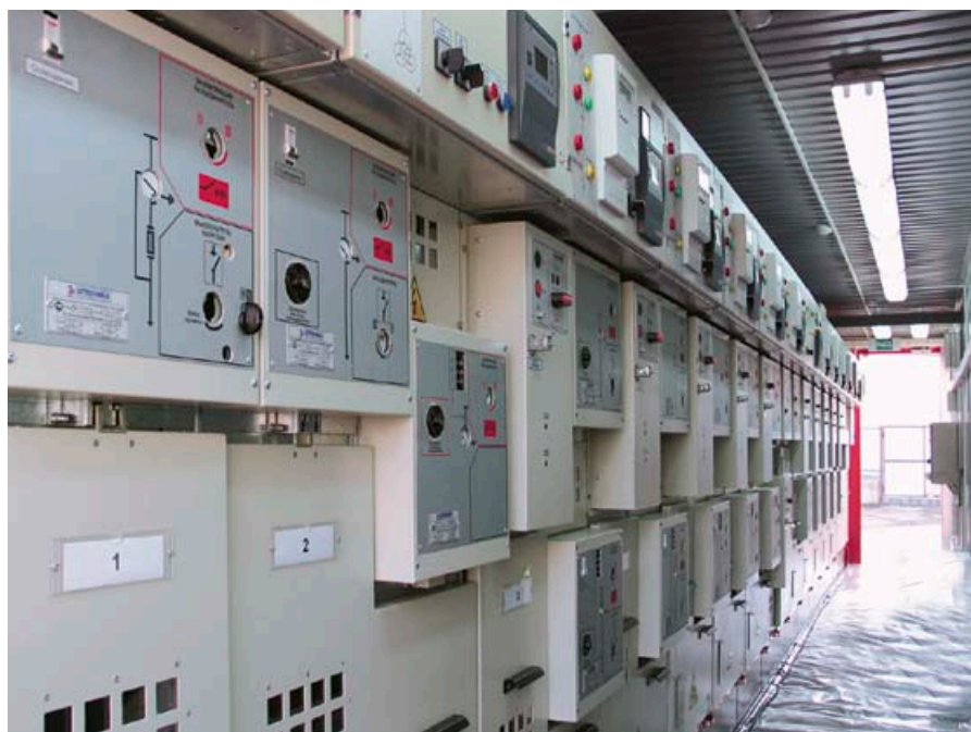
Распределительное устройство в металлической оболочке на базе ячеек КСО «Онега»
