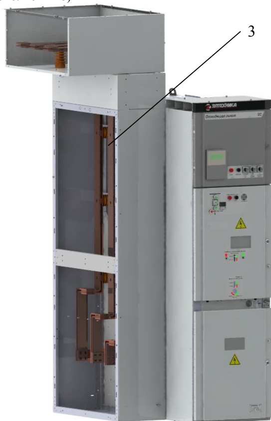
Рис. 36. Сборка шинного ввода сбоку шкафа КРУ
