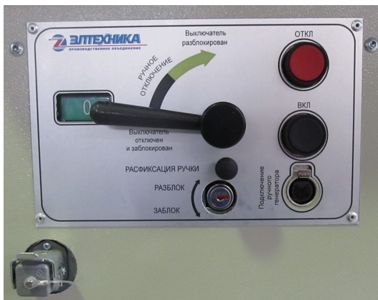
Рис.6в Рукоятка отключения заблокирована.
